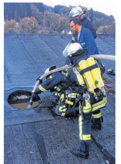
Der Brand im Pulper im Papierwerk wurde durch das Dach gelöscht.
